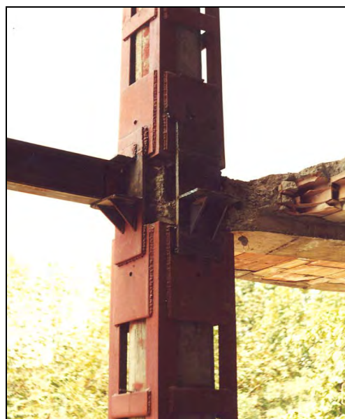
شکل ۱۲-۵-۲- نمونه‌ای از روکش فولادی جهت افزایش مقاومت خمشی ستون
