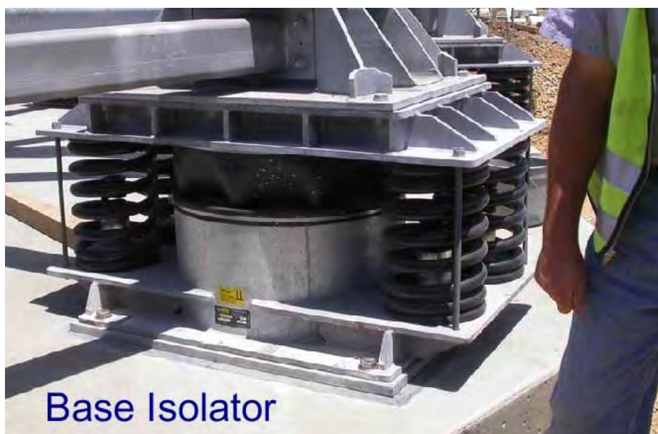
شکل ۶-۱۲- جداگر GERB
