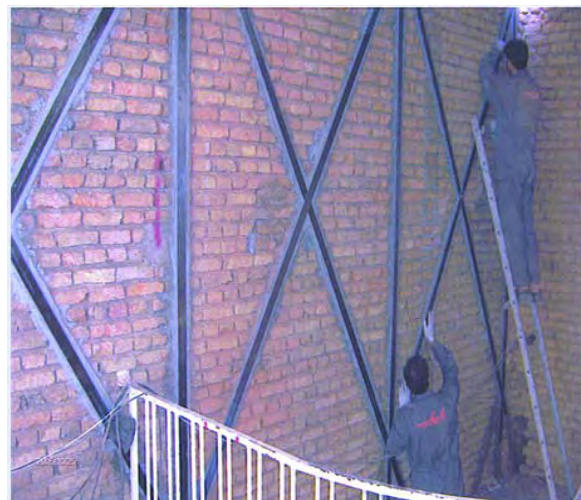
شکل ۸-۱۹ - نحوه اجرا و نصب نوارهای FRP
