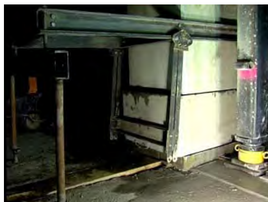
شکل ۶-۱۹ - خروج بلوک بریده شده
