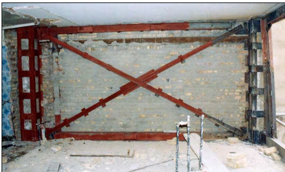
شکل ۴-۵- بهسازی قاب‌های موجود بوسیله مهاربندهای همگرا
