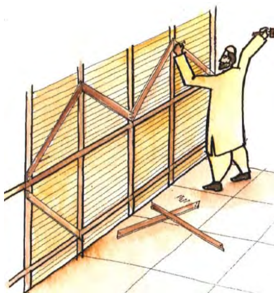
شکل ۹-۳۸ پیوستگی اعضای قطری
