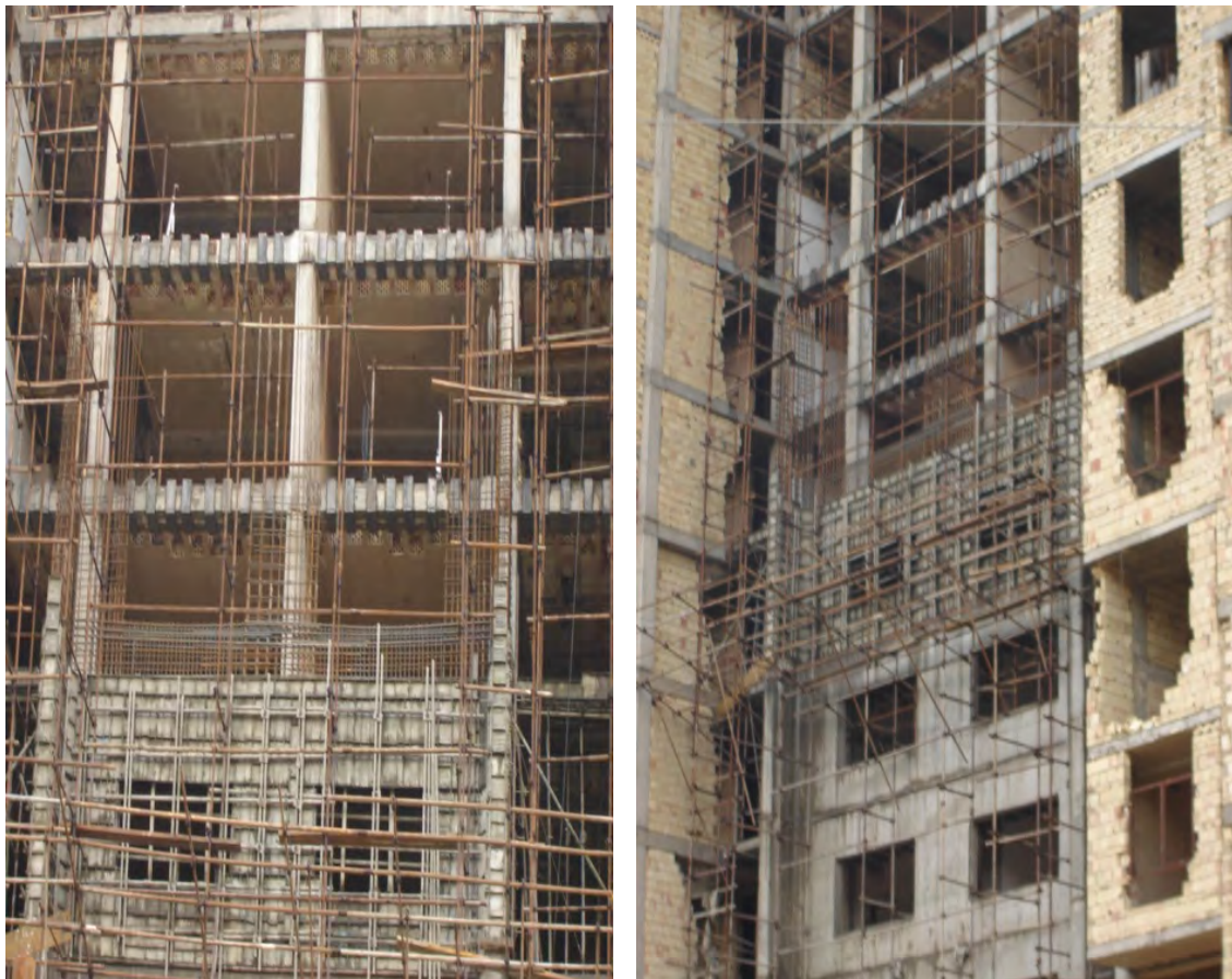
شکل ۴-۴۷ - افزودن میانقاب بتنی به عنوان دیوار برشی
