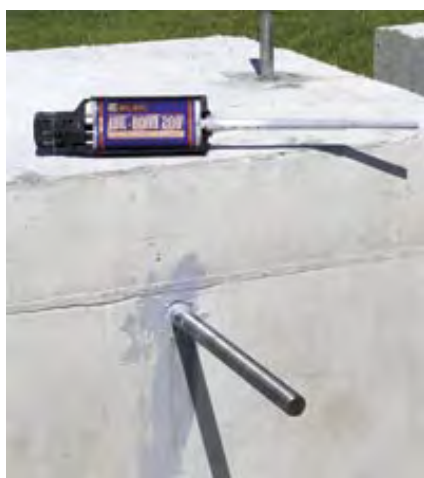
شکل ۲-۱-۲- کاشت پیچ به کمک مواد اپوکسی داخل کپسول
