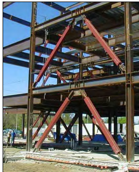
شکل ۴-۱۹- نمونه‌هایی از مهاربند ضد کمانش BRBF
