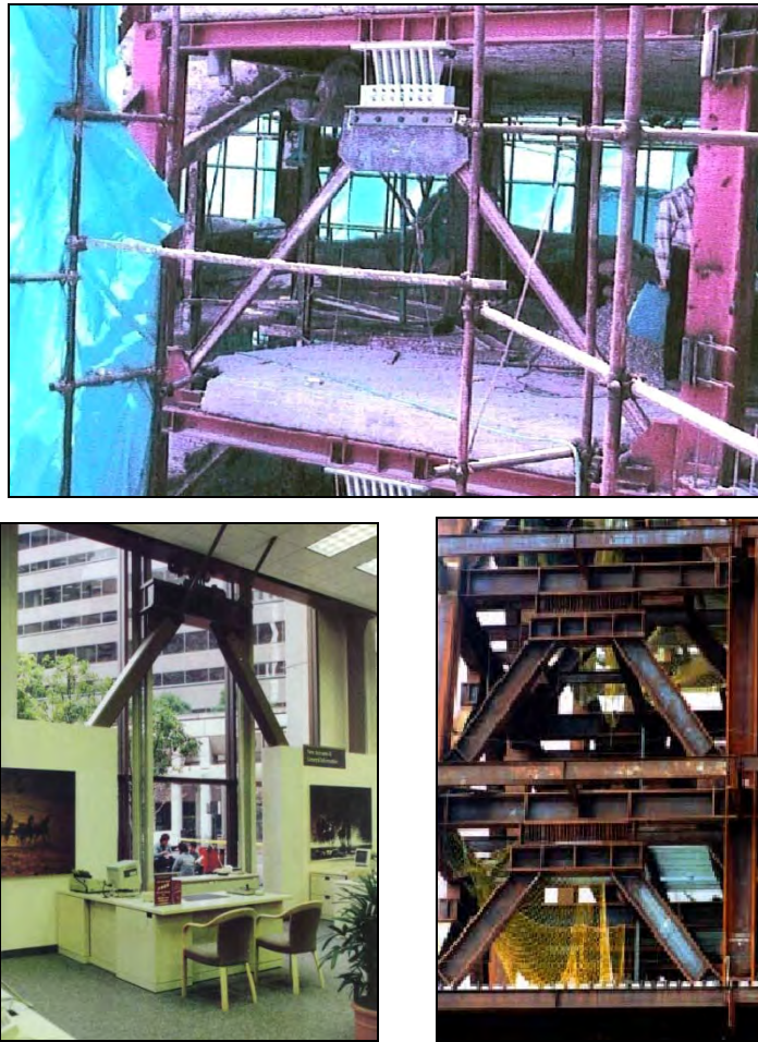
شکل ۷-۱۳- نمونه هایی از بکارگیری میراگر T-ADAS
