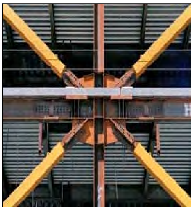
شکل ۴-۱۹- نمونه‌هایی از مهاربند ضد کمانش BRBF
