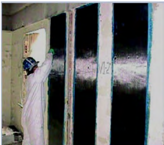
شکل ۸-۱۹ - نحوه اجرا و نصب نوارهای FRP
