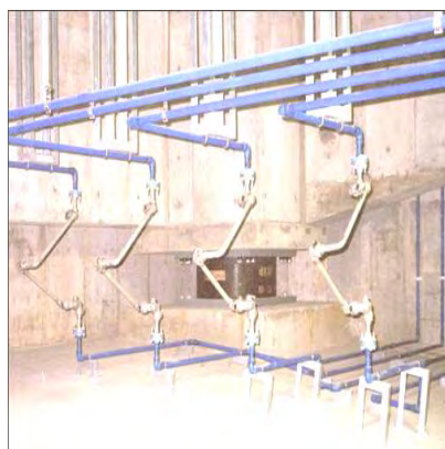
شکل ۶-۲۲ - استفاده از اتصالات مناسب برای تاسیسات مکانیکی و برقی در تراز جدا شده
