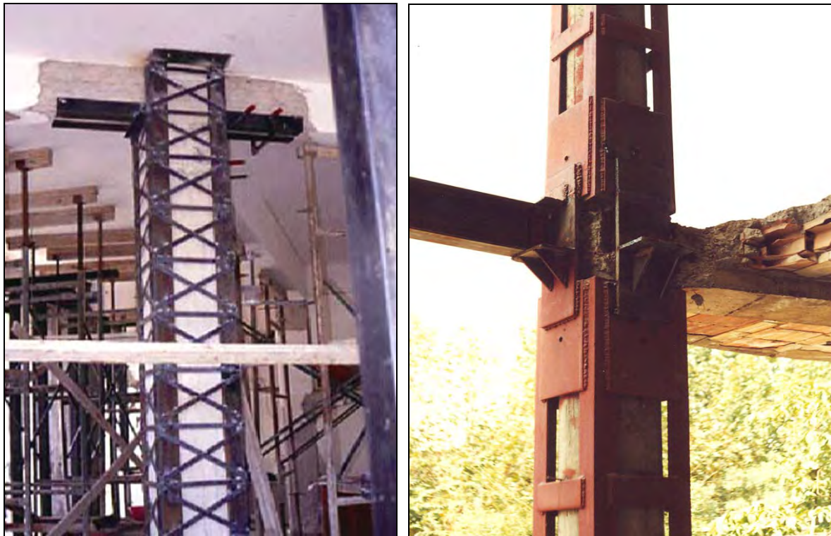
شکل ۲-۶-۲۵ روش‌های بهسازی اتصالات میانی
