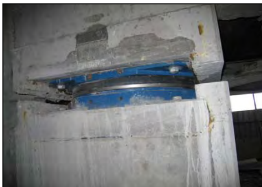
شکل ۶-۱۱ - جداگرهای اصطکاکی FPS
