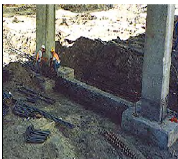
شکل ۴-۲-۲- به هم بستن شالوده‌ها با شناژ
