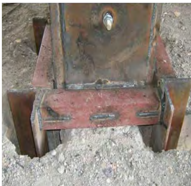
شکل ۱۲-۵-۲- نمونه‌ای از روکش فولادی جهت افزایش مقاومت خمشی ستون
